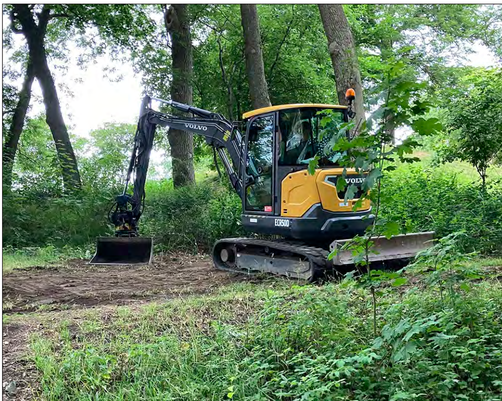
Figur 5. Fältarbetet vid utredningen gjordes med hjälp av en mindre grävmaskin.
